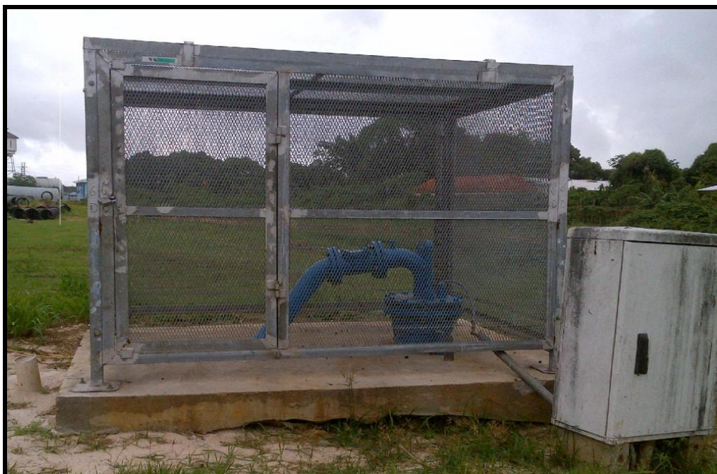
Figuur 4: Foto van een bron (pompput)
