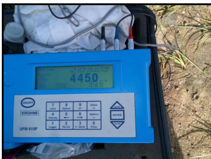
Figuur 19: De debietmeter die het gefiltreerde water meet
